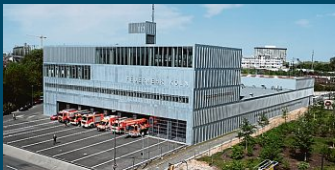
Die neue Feuerwache in Kalk ist ein markanter Akzent in städtebaulich schwierigem Umfeld.
