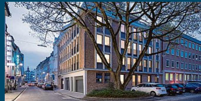
Die evangelische Kirche hat ein 50er-Jahre-Bürohaus zu einem Wohnhaus für Flüchtlinge umgebaut.
