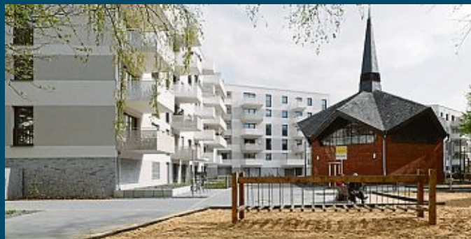
Neues Wohnquartier an der Holsteinstraße rund um die alte Kapelle, die jetzt als Nachbarschaftstreff genutzt wird.
